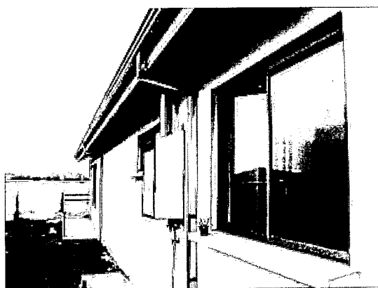
Fotografía N° 14: Detalle de la solución de canales utilizada por el contratista.
